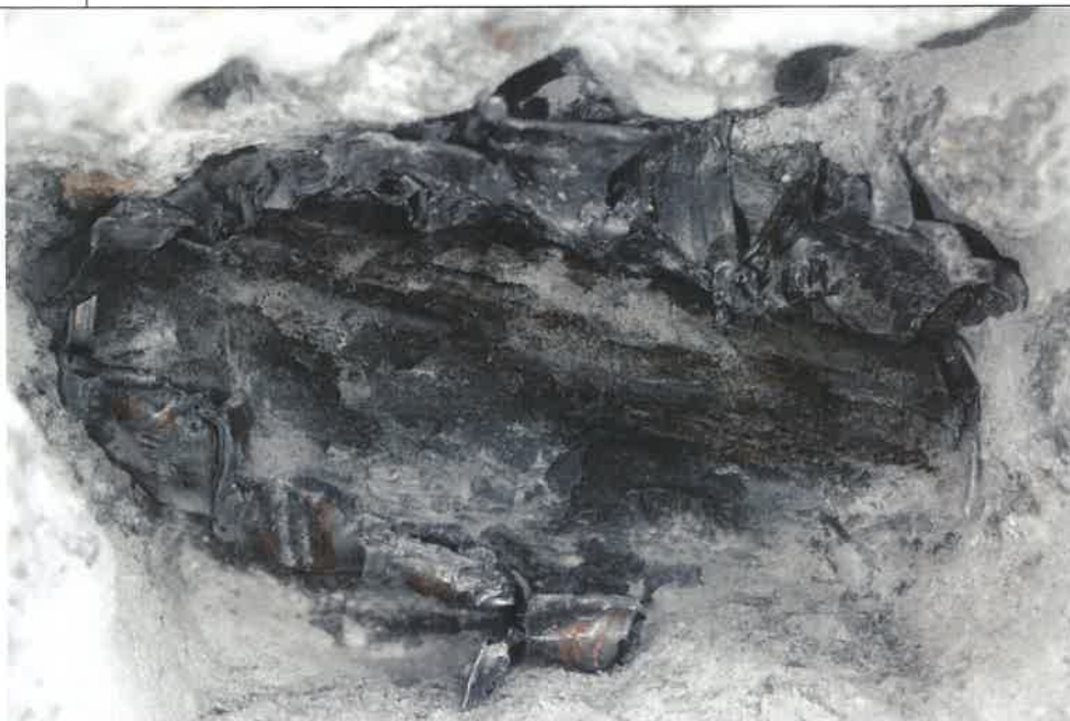
vlhká malta, v horní oblasti nevyplněno injektážní maltou
