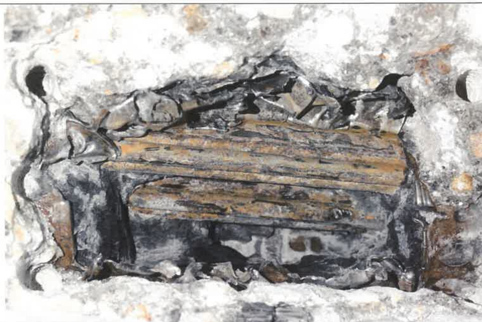
výrazná povrchová koroze výztuže
