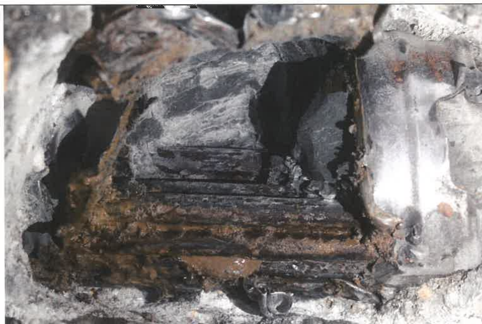
výraznější povrchová koroze drátů, výtoky vody z prostoru mezi nimi
