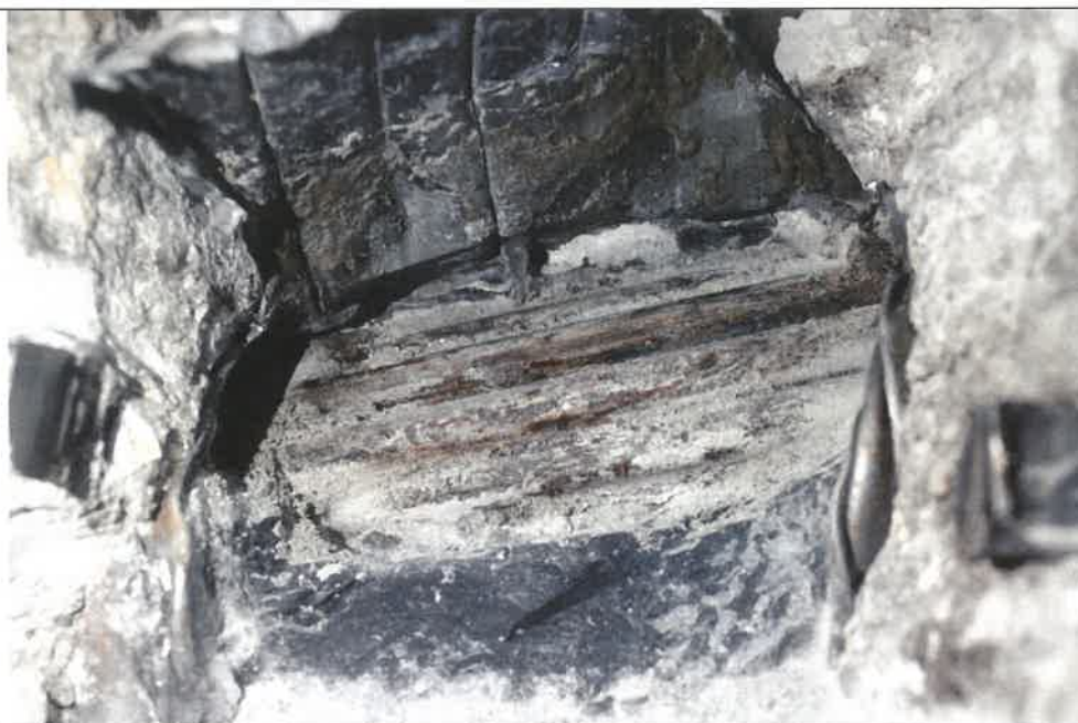
výraznější povrchová koroze výztuže
