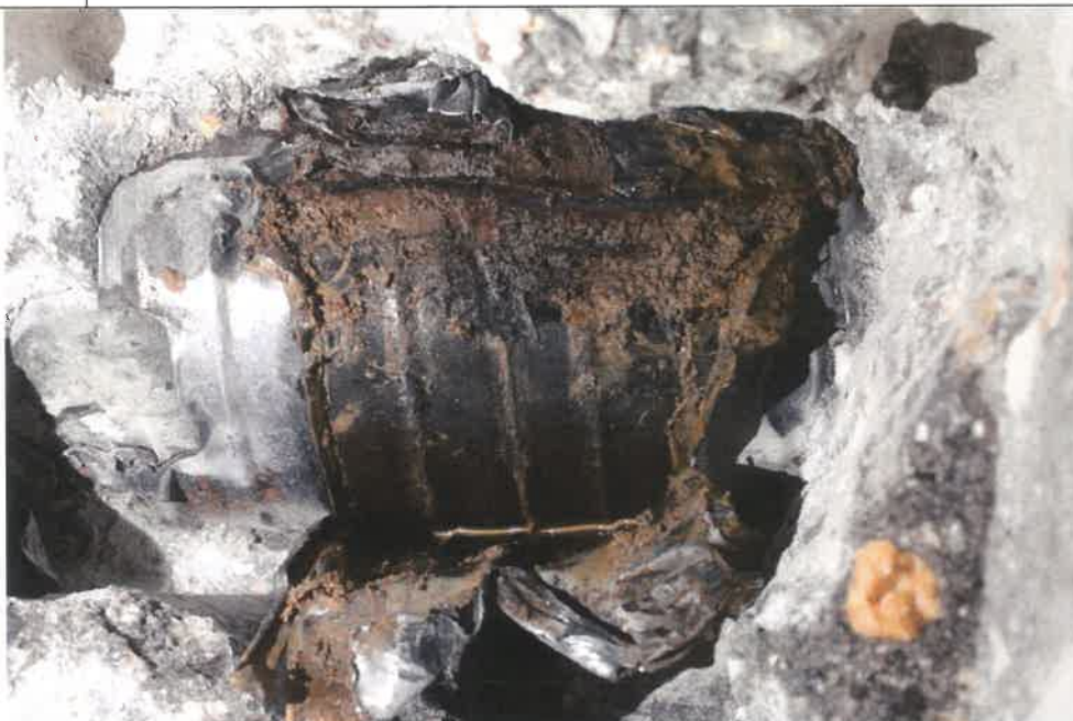
výrony vody po otevření chráničky podél její stěny
