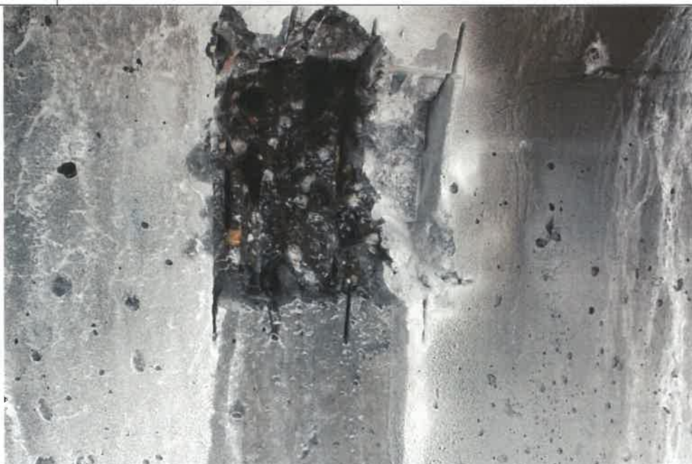
výtok vody po navrtání chráničky
