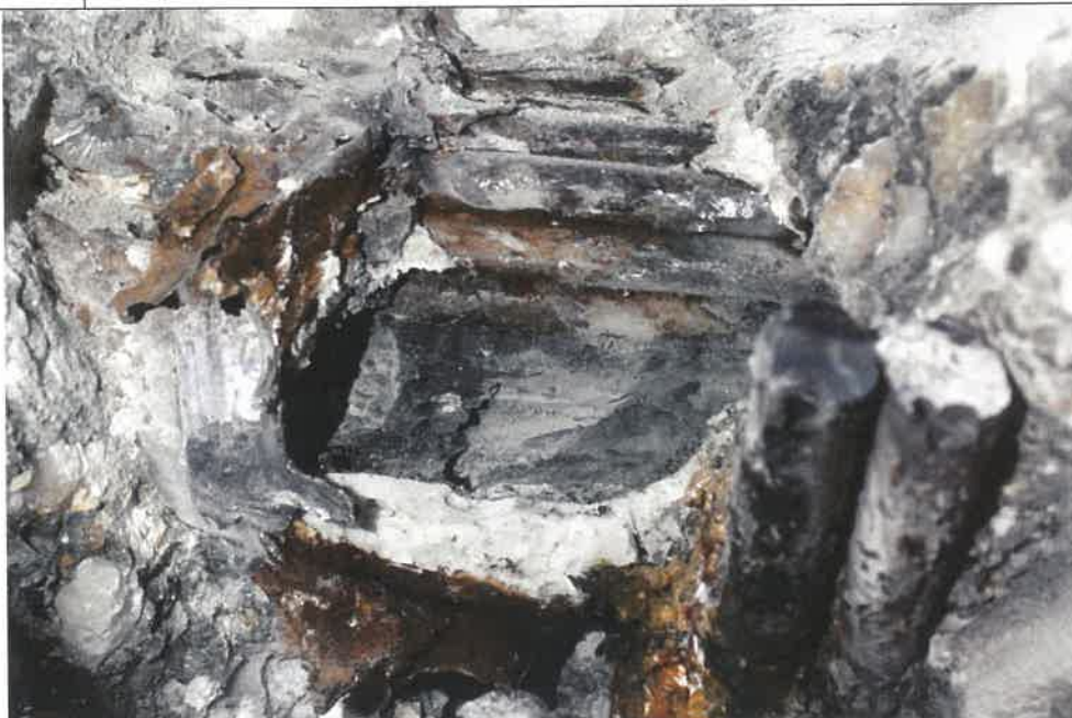
silná koroze chráničky, mírná povrchová koroze drátů
