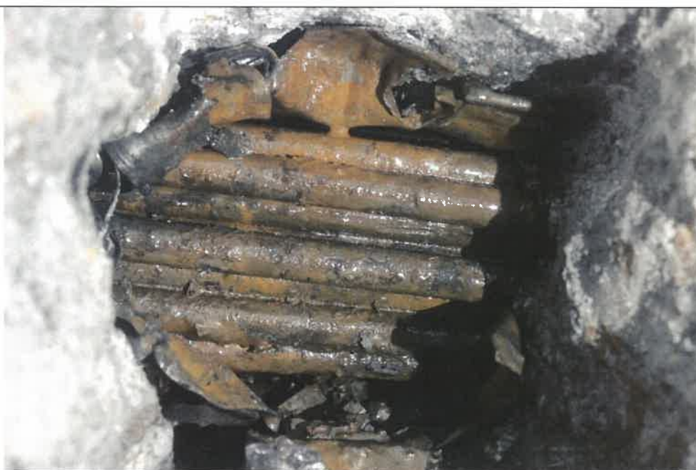
obnažená zkorodovaná výztuž v zcela mokrému prostoru chráničky
