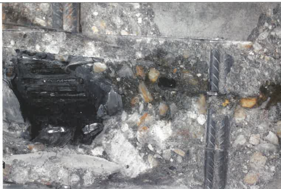
výtok vody po otevření chráničky z dutiny nad výztuží
