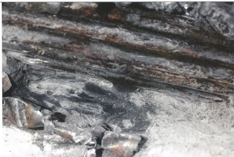
výraznější povrchová koroze výztuže
