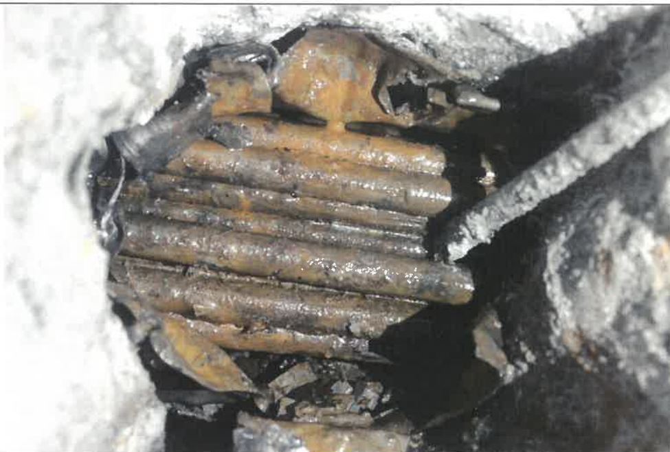
volný drát ve svazku – pohyb patrný při porovnání s předcházejícím snímkem
